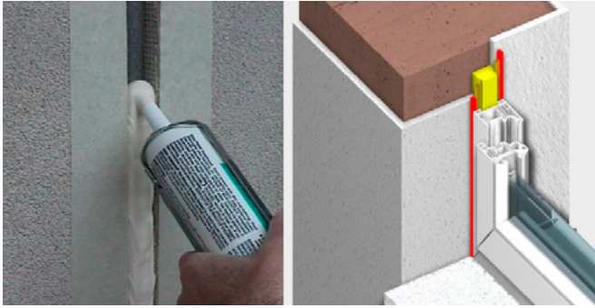
Figura 3. Exemplos típicos de aplicações de selantes de silicone em construção
